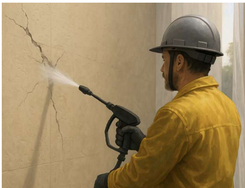
Figura 17 - Hidrojateamento da fachada. Fonte: O Autor (2025).
