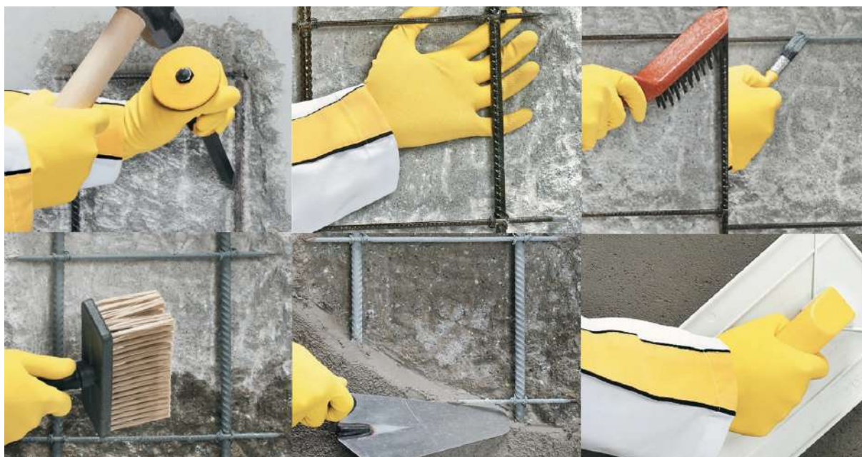
Figura 18 - Principais fases da recuperação estrutural. Fonte: Adaptado de Quartzolit.
