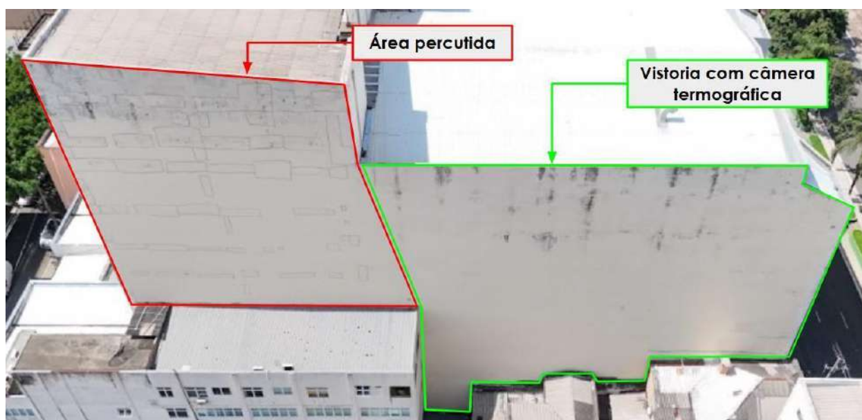
Figura 3 - Região das descidas realizadas e vistoria de drone com uso de câmera termográfica na fachada lateral esquerda. Fonte: O Autor (2026).
