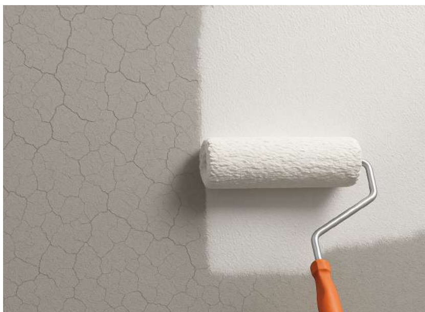
Figura 19 - Processo de recuperação das fissuras mapeadas. Fonte: O Autor (2025).
