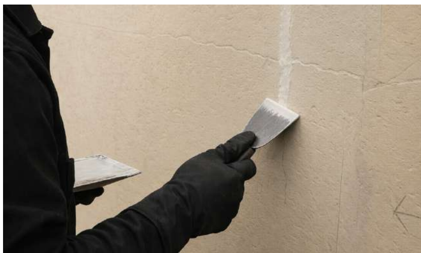
Figura 20 - Processo de recuperação das fissuras. Fonte: O Autor (2025).
