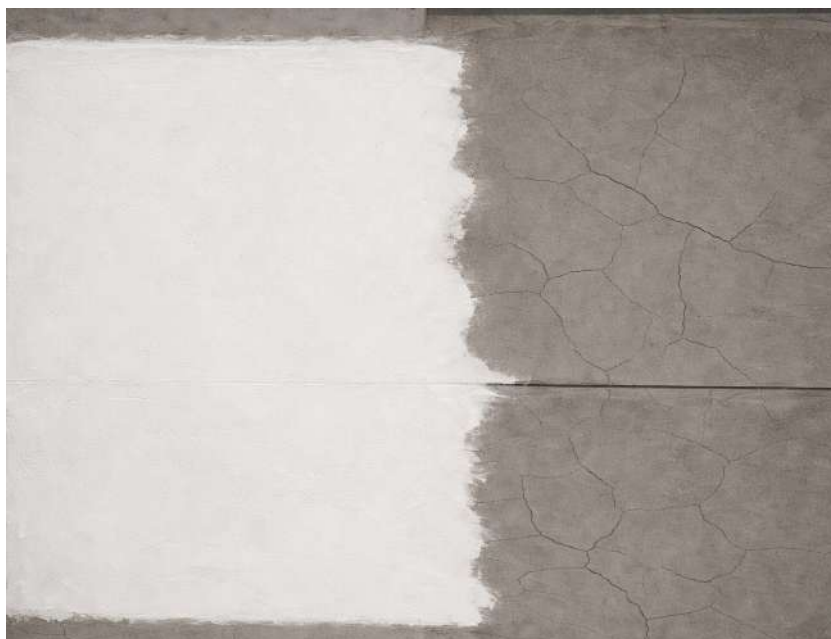
Figura 22 - Processo de recuperação das fissuras. Fonte: O Autor (2025).
