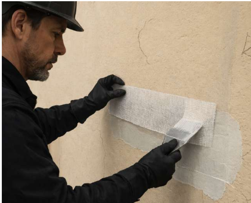
Figura 21 - Processo de recuperação das fissuras. Fonte: O Autor (2025).
