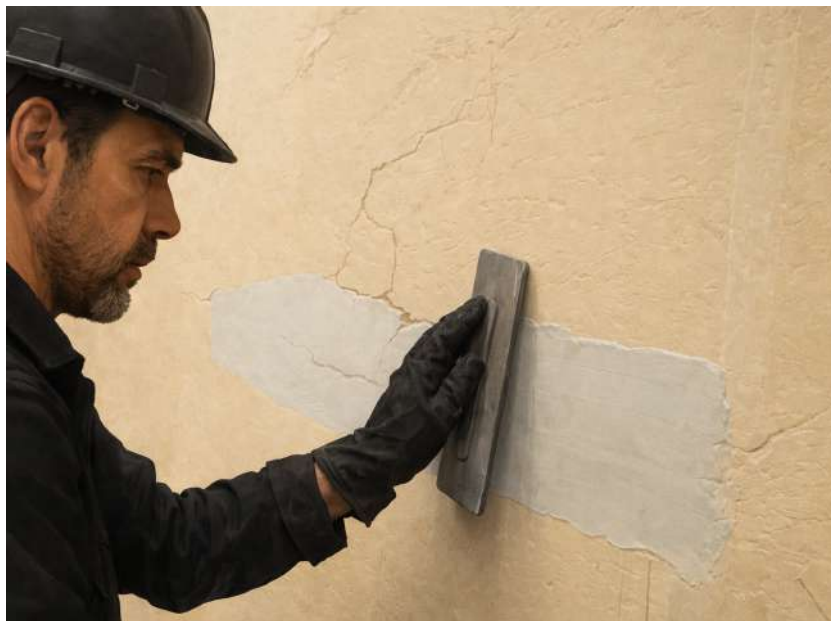
Figura 20 - Processo de recuperação das fissuras. Fonte: O Autor (2025).
